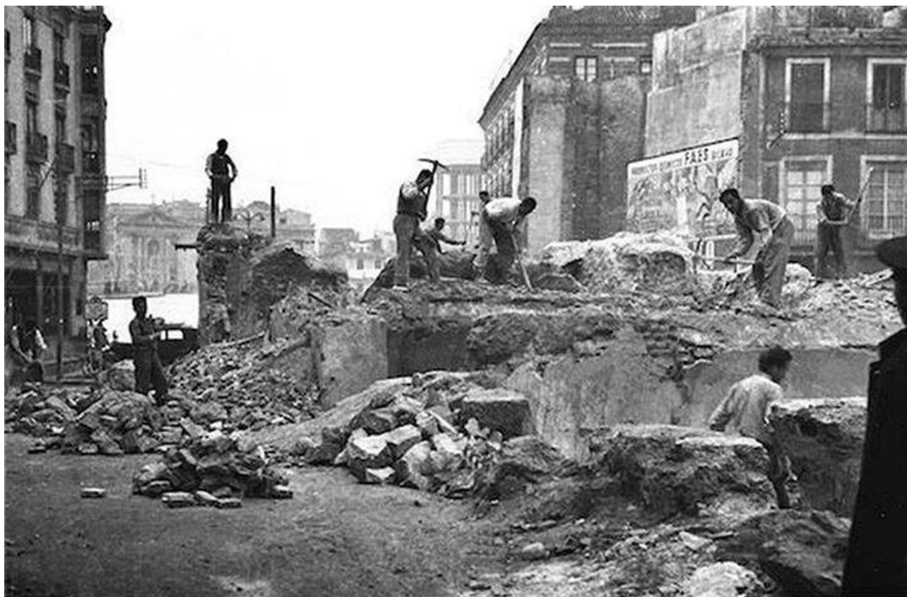
Destrucción “a pico y pala” de los baños musulmanes.
