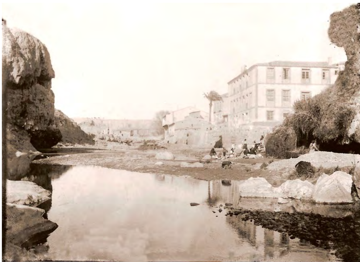
En primer término, vista de Parador del Intendente y, al fondo la zona de La Misericordia.
