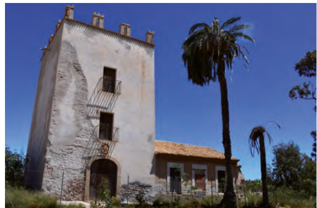
Figura 1. Torre de Rame y vivienda anexa.
