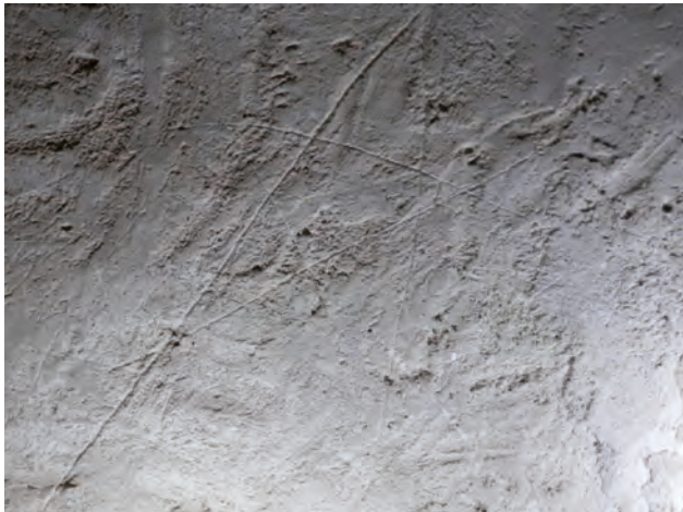
Figura 3. Pentalfa trazada en el muro de la caja de escalera.
