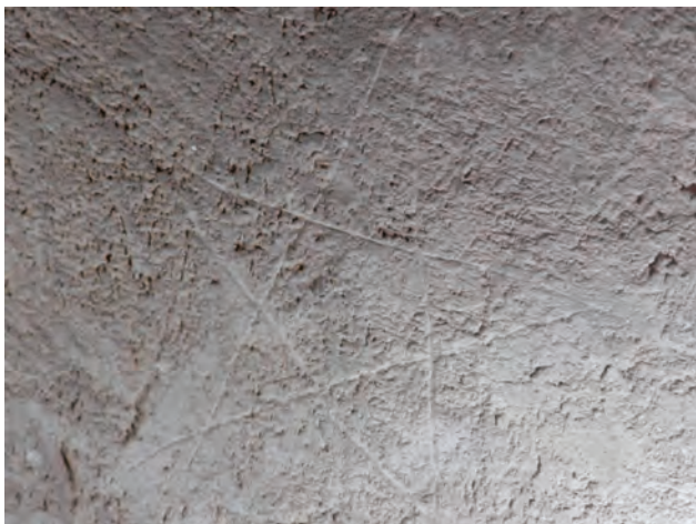
Figura 4. Pentalfa trazada en el muro de la caja de escalera.
