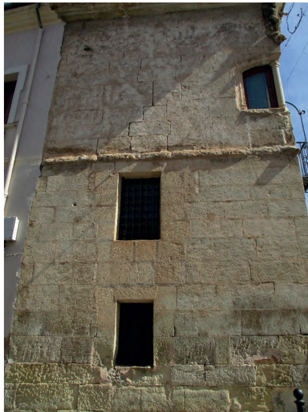
Figura 3. Las Reales Cárceles de Yecla ocupaban los bajos de la Casa Consistorial. Eran lóbregas e insalubres y en ellas estuvo preso Matías Herrero Melero acusado de violar a la esclava Antonia Francisca en 1718.
