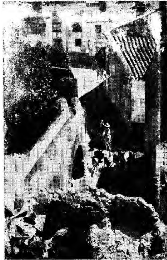
Arcada que conducía el agua desde Los Caños al Molino.
