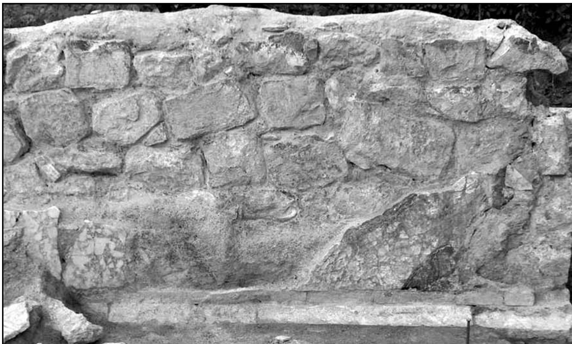
Lámina 13: Detalle del rodapié en kyma reversa, placas niveladoras y restos de las placas en “africano” y “pavonazzetto” que revestían la pared.
