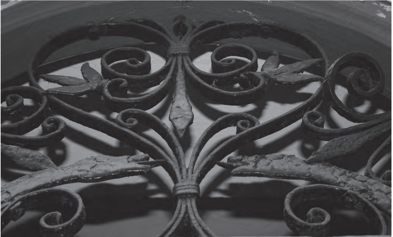
Rejería protectora de las casas
