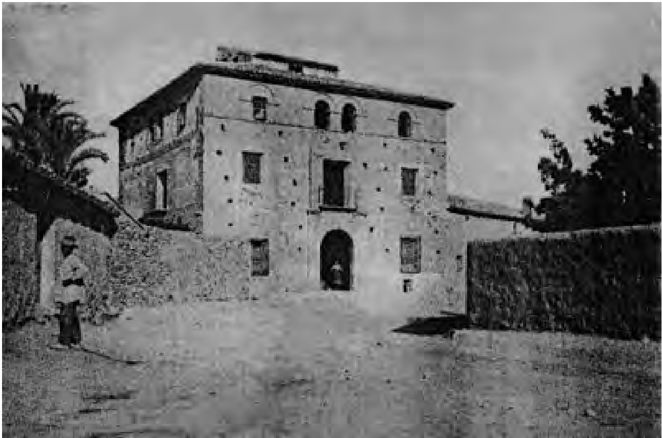
Casa Cayitas, circa 1900. Archivo Histórico Municipal de Alcantarilla
