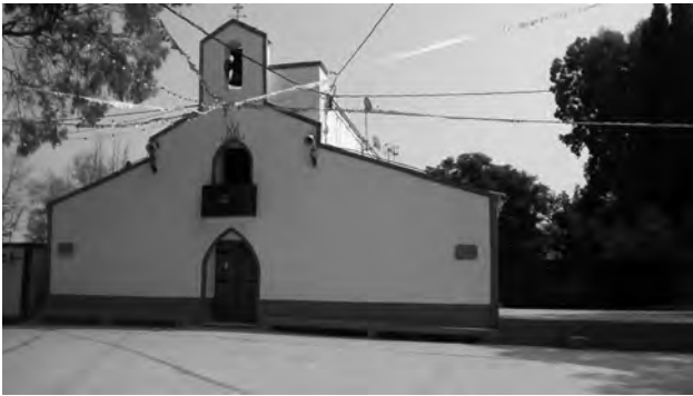
La ermita de Belén se ofrece como referente de protección y seguridad
