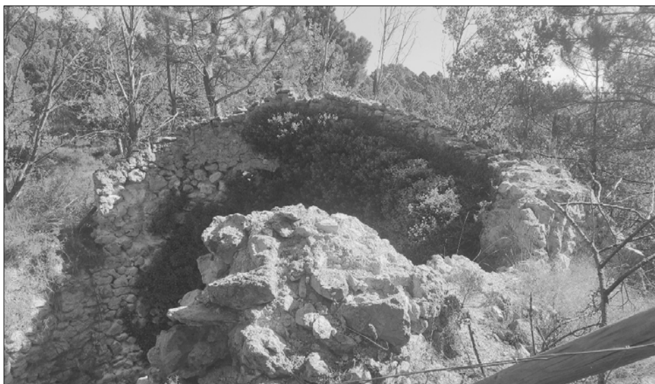
Cámara circular y arranque de la bóveda del pozo de nieve del Nevazo (Foto J. López)
