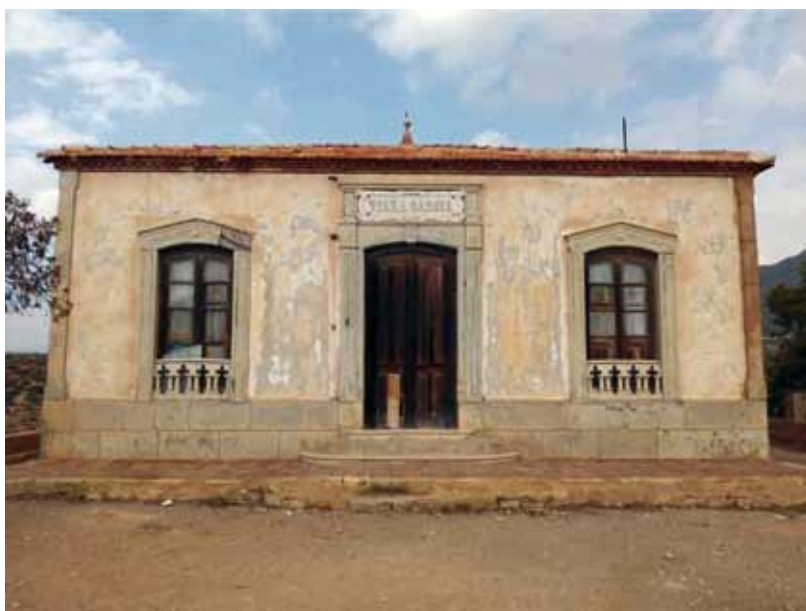
Figura 2: fachada de Villa García
