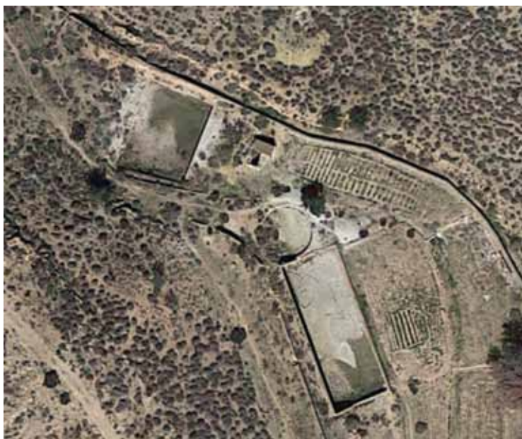
Figura 6: imagen aérea del conjunto de balsas de la finca junto a supuesta desembocadura del qanat y tomaor.
