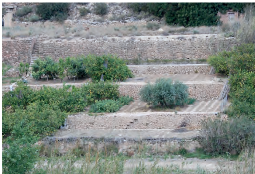
Fig.6. Terrazas de cultivo en ladera construidas con muros de piedra seca. Margen izquierda del río, próximo a la noria de La Ribera (Ojós)
