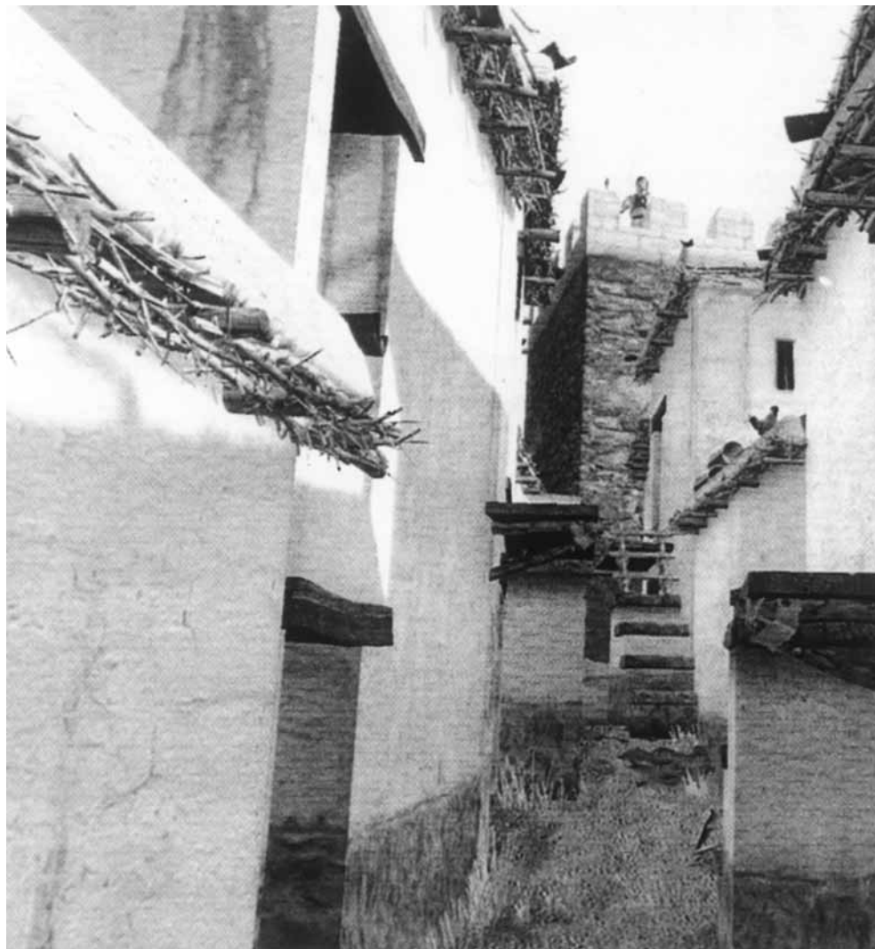
FIGURA 4. Vista de la estructura interna del Puntal dels Llops según H. Bonet y C. Mata
