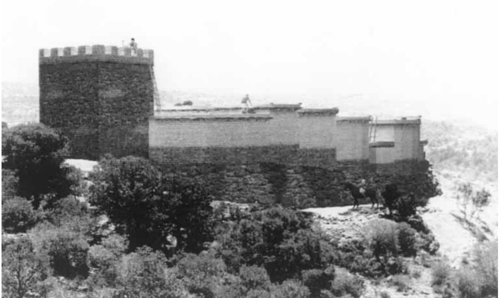
FIGURA 2. Reconstrucción hipotética del emplazamiento de El Puntal dels Llops (Valencia) según H. Bonet y C. Mata. Se aprecia el sistema constructivo con amplio zócalo de piedra, alzados de adobe y techumbres planas. El sistema defensivo pivota en la gran torre que domina el caserío.
