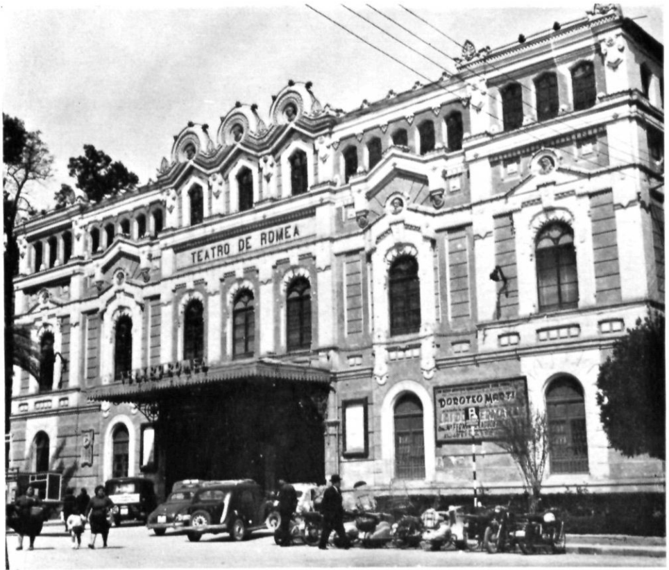
Fachada principal del Teatro Romea en la actualidad
