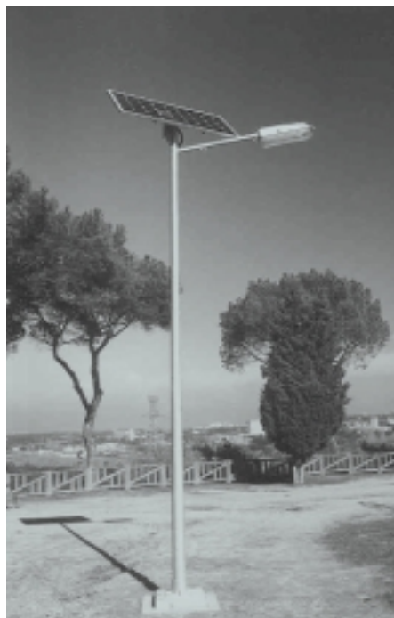
Farola Fotovoltaica en la Casa de Campo de Madrid
